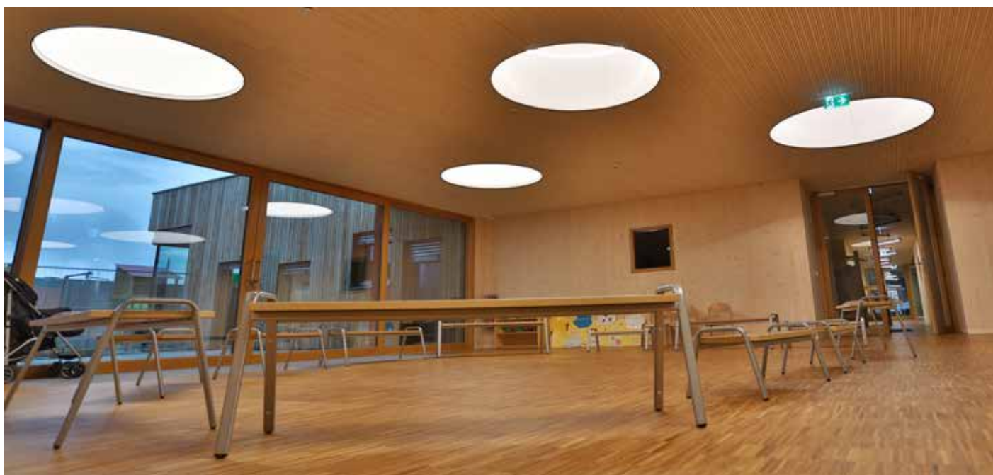
Abbildung 5: Lichtdecken fungieren als »künstliche Fenster«, die räumliche Tiefe erzeugen. Foto: Christoph Baumann / Guttenberger
